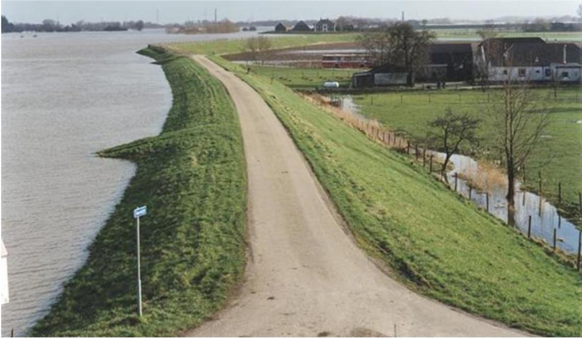
*Gambar 16. Sebuah polder di Jijmegen, Belanda. Perhatikan air sungai (di sebelah kiri) yang lebih tinggi dari permukaan lahan (kanan). Tanggul-tanggul besar harus dibangun di sekeliling polder (sekaligus berfungsi sebagai jalan dalam gambar diatas) dan harus dirawat secara rutin. Jika terjadi kegagalan tanggul, air sungai dari kiri akan membanjiri polder di kanan.*
